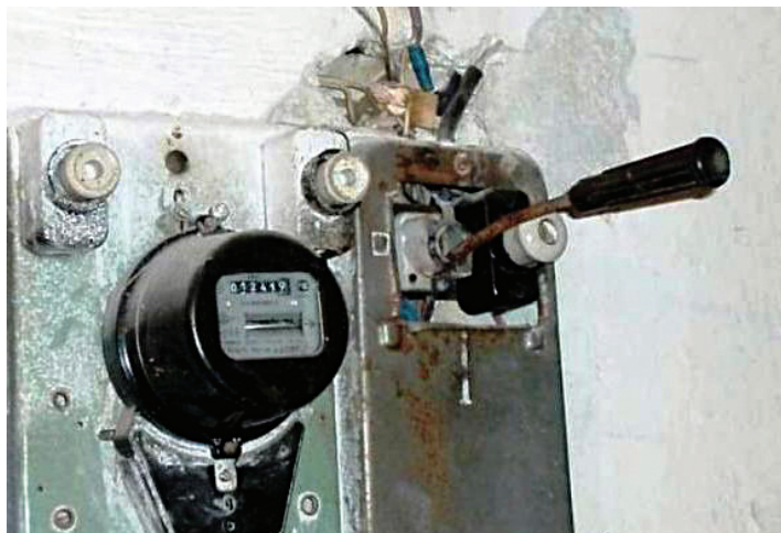
«Жучок» в электросетке - пример наплевательского отношения к собственной безопасности
